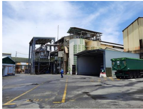
Figure 3 - Photographie du bâtiment de l'usine GARDEL
