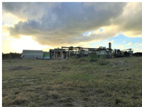
Figure 4 : Vue depuis le site de projet vers l'usine de GARDEL au Sud
