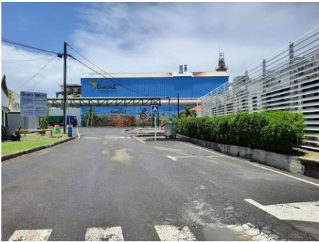
Figure 2 - Photographie du bâtiment de l'usine GARDEL
